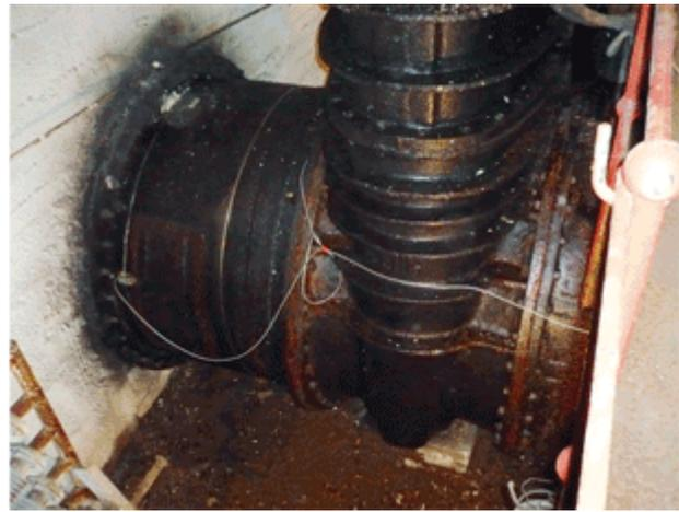
**Рис.2. Установки для учета расхода воды на трубопроводах больших диаметров:
