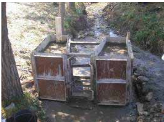
а) при помощи переносной опалубки б) монтаж лотка заводского изготовления Рис.4. Строительство гидропостов с лотками "ВЛС".
